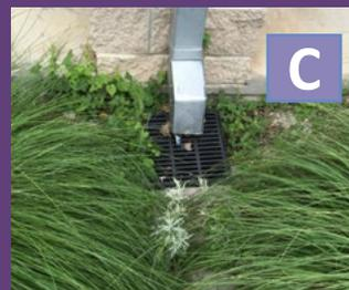
Bajante desviado hacia una cuneta mediante la cuenca de captación y la tubería subterránea.
